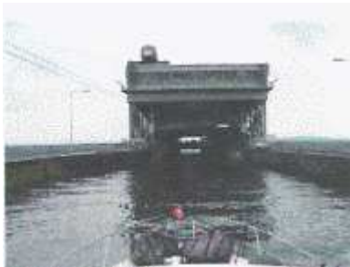
Ansicht von Oberwasser
