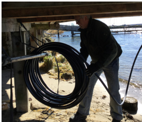
In Eigenarbeit: Wasserleitung ziehen ...
