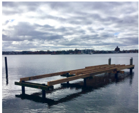
Die Längsbalken werden erneuert
