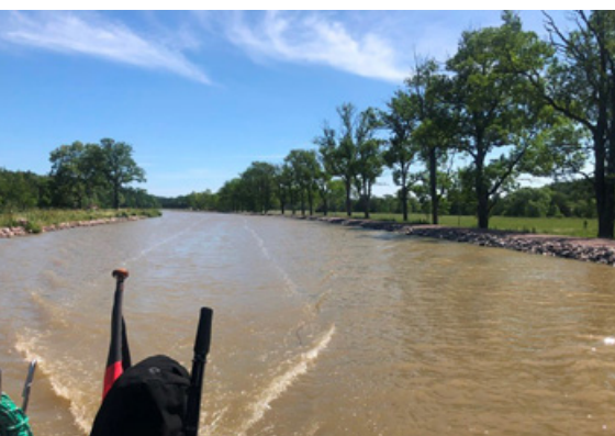
Neu ausgebaute Kanalstrecke (Fotos Hartmut Pflughaupt)
