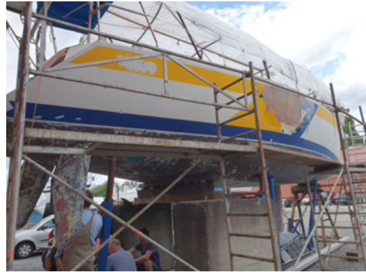
Das Schiff ist für die Malerarbeiten eingerüstet
