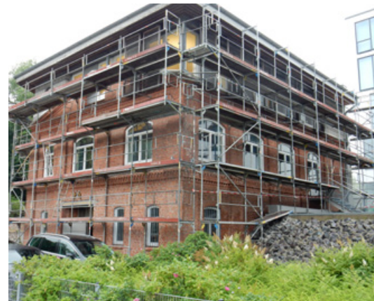
Das eingerüstete Clubhaus
